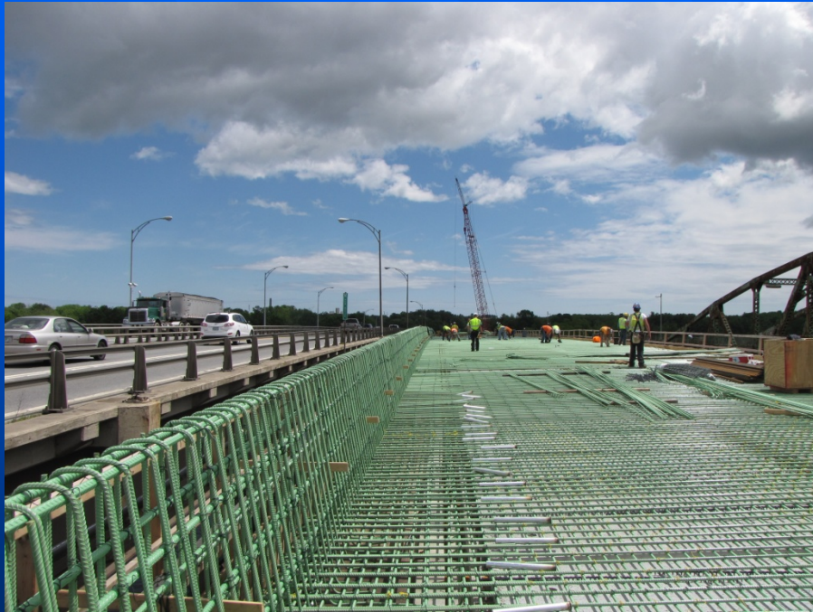
Deck Reinforcing Steel and Concrete Pour (2012)
