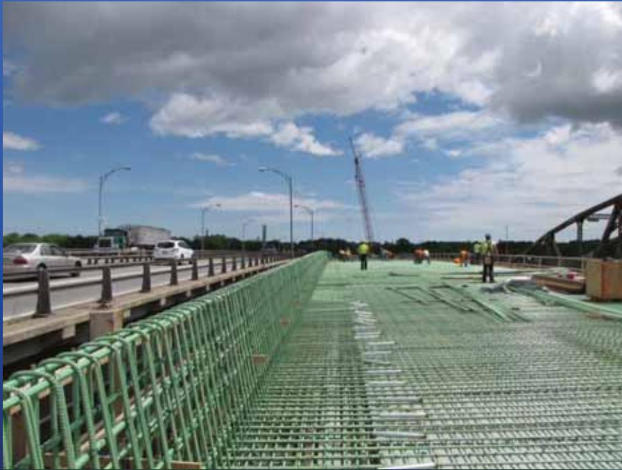
Deck Reinforcing Steel and Concrete Pour (2012)
